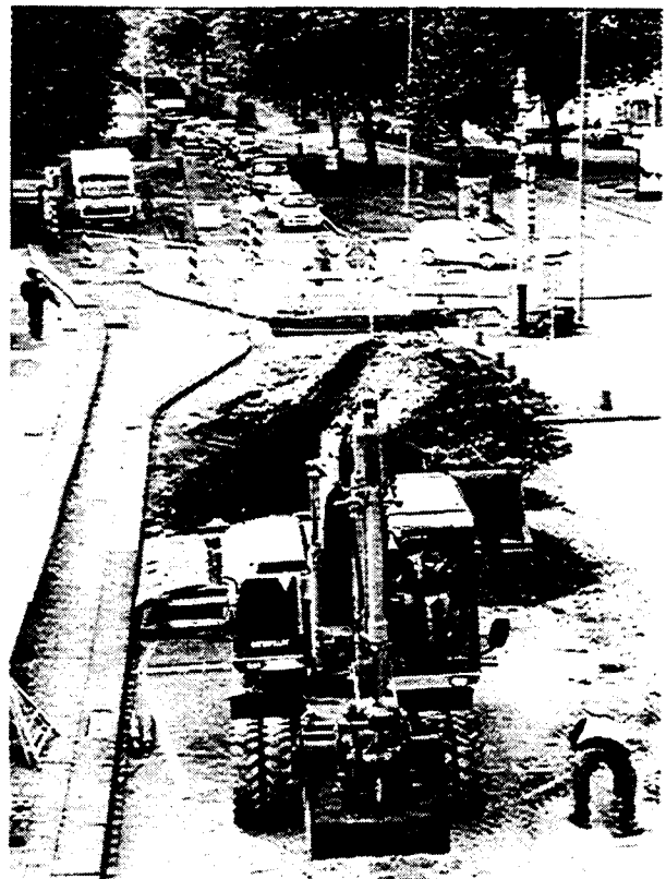
Eerste tekenen van een bouwput. De proefsleuf die werd gegraven ter hoogte van Bistro Postma. Archeologen zoeken naar de oude kadewand.
